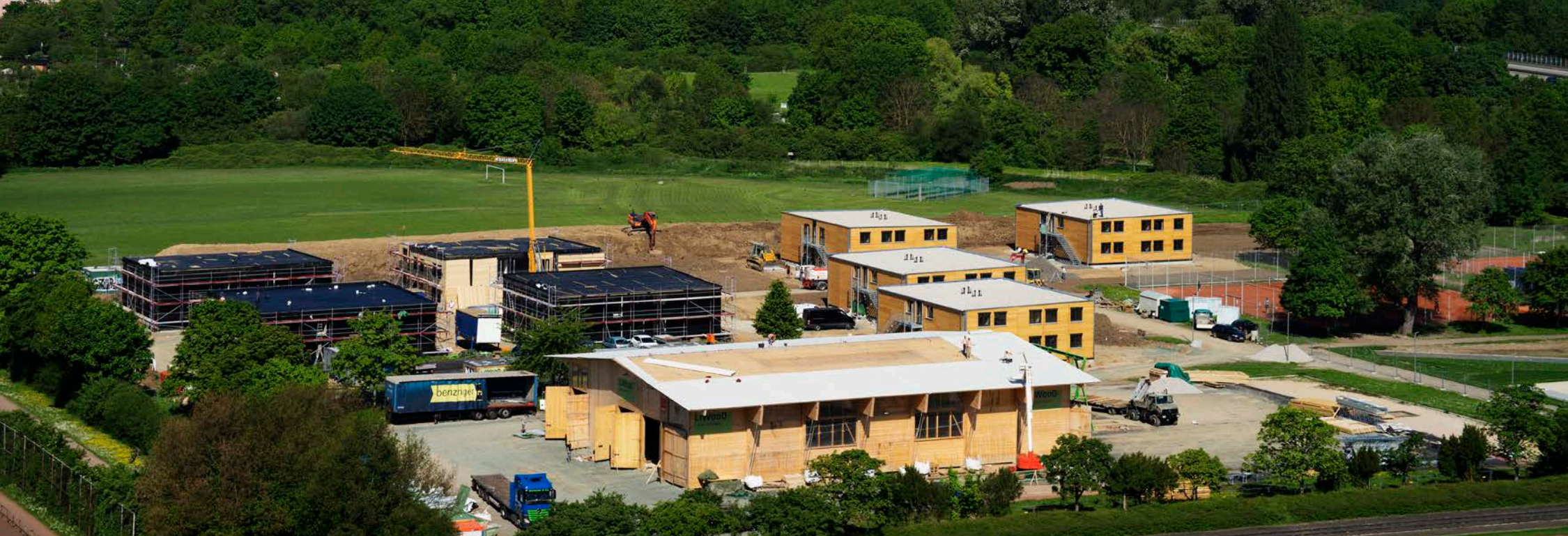
Projekt in Frankfurt Ginnheim - Feldfabrik direkt auf dem Baugrund
