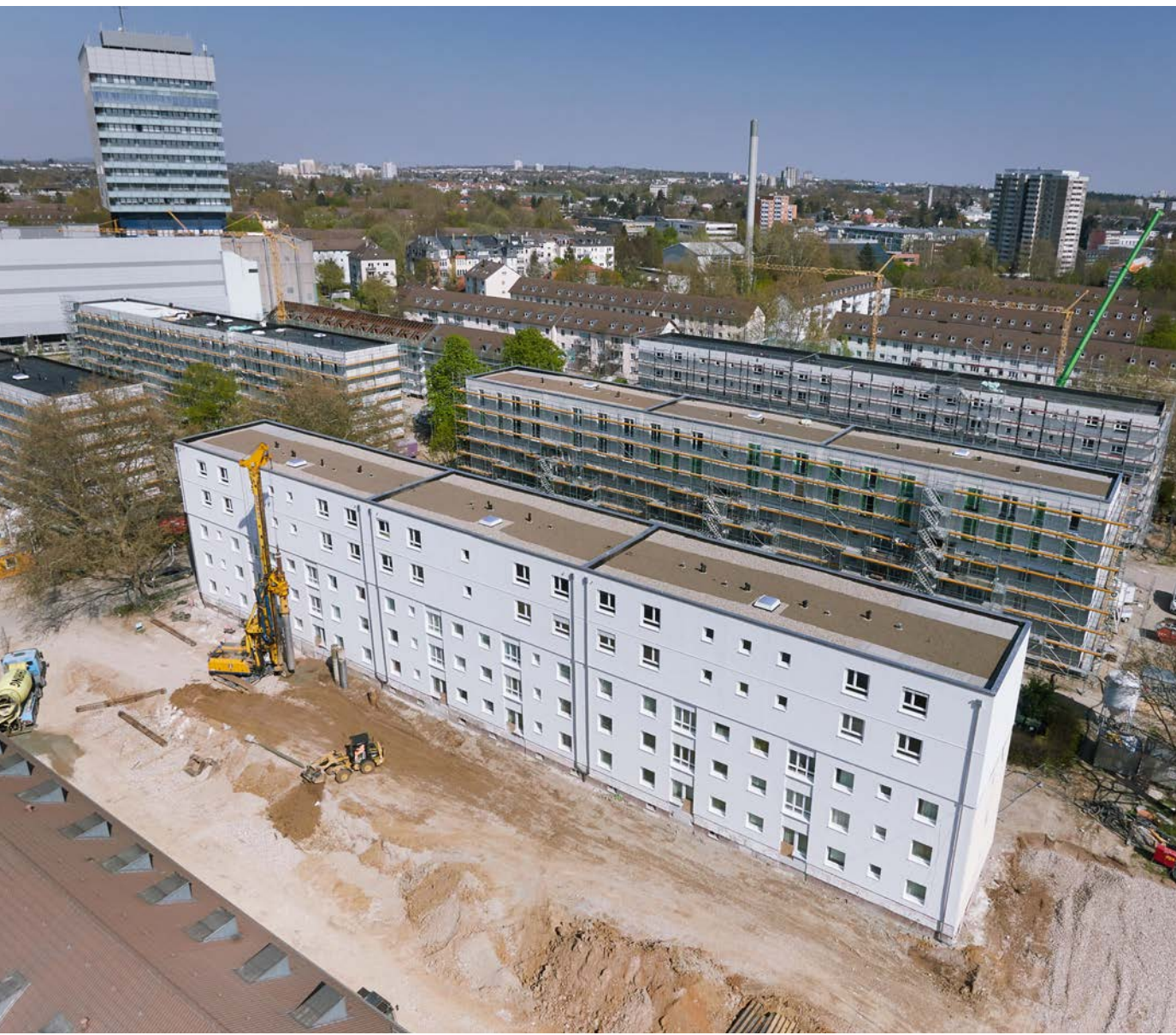
Luftaufnahme der Platensiedlung - Gebäude in unterschiedlichen Ausbaustufen
