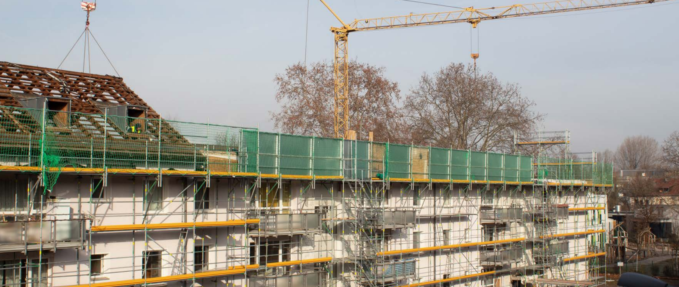
Dächer werden durch die Aufstockung ersetzt - ein Mehrwert für den Bestand
