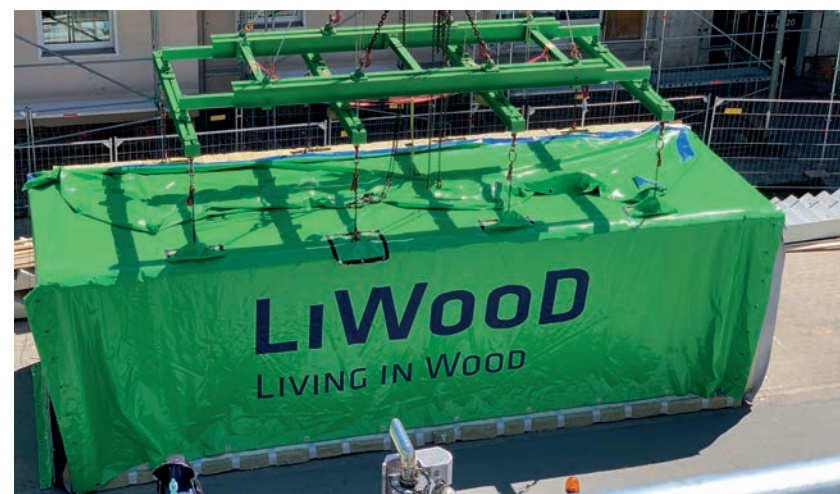
Anlieferung von Modulen im 1,5 Stunden-Takt
