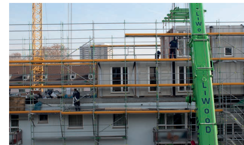
Versetzen der Module zum Gebäude
