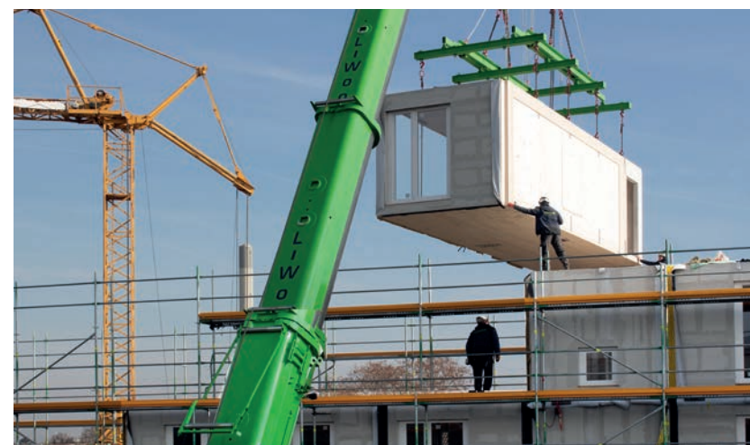
Positionieren der Module
