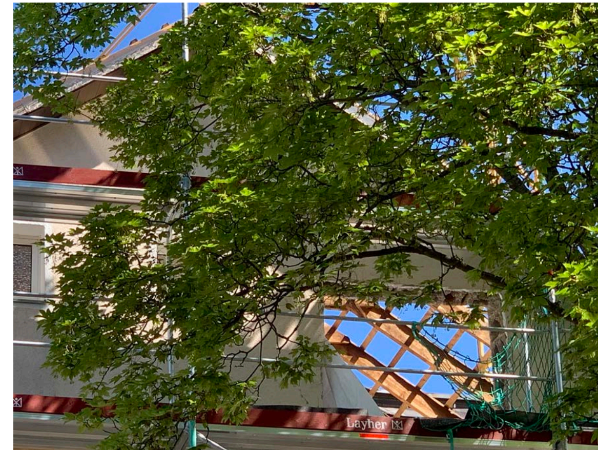
Rückbau der Dächer des Altbestandes
