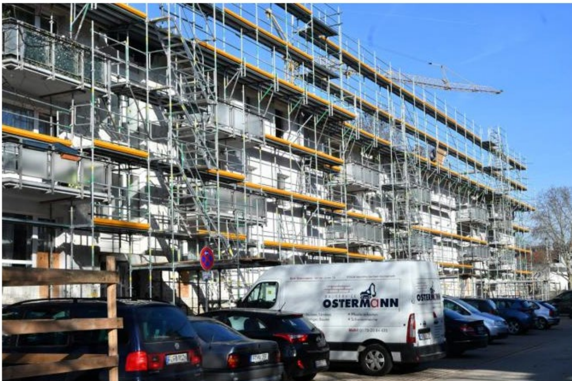
Wohnungsbau in Ginnheimer Platensiedlung mit Holzmodulen aus der LiWood-‘Feldfabrik’
