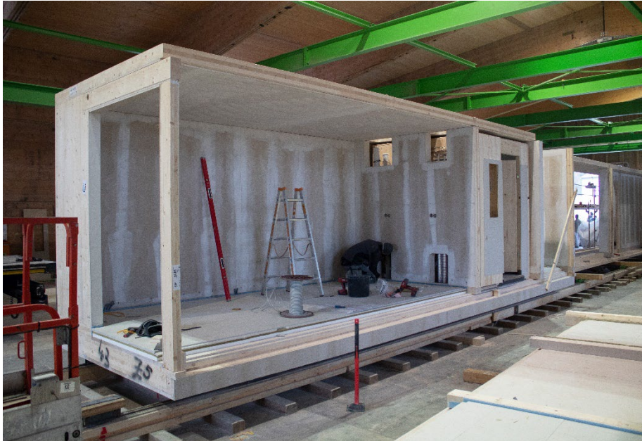
Die innerhalb eines Tages gefertigten Module werden sofort im Anschluss zum Gebäude versetzt
