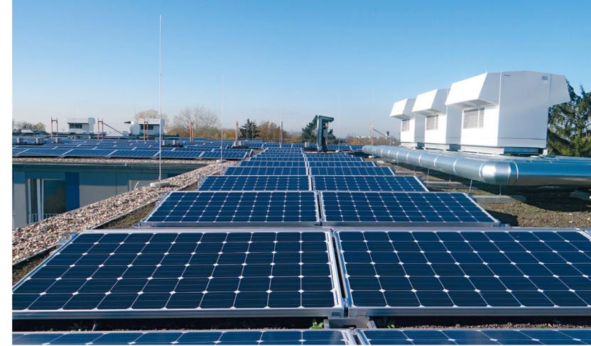
Die auf dem Flachdach installierten Photovoltaik-Elemente erzeugen den für den Betrieb der Luft-Wasser-Wärmepumpen – sie liefern ihrerseits die Energie für Heizung und Warmwasserbereitung – benötigten Strom.
