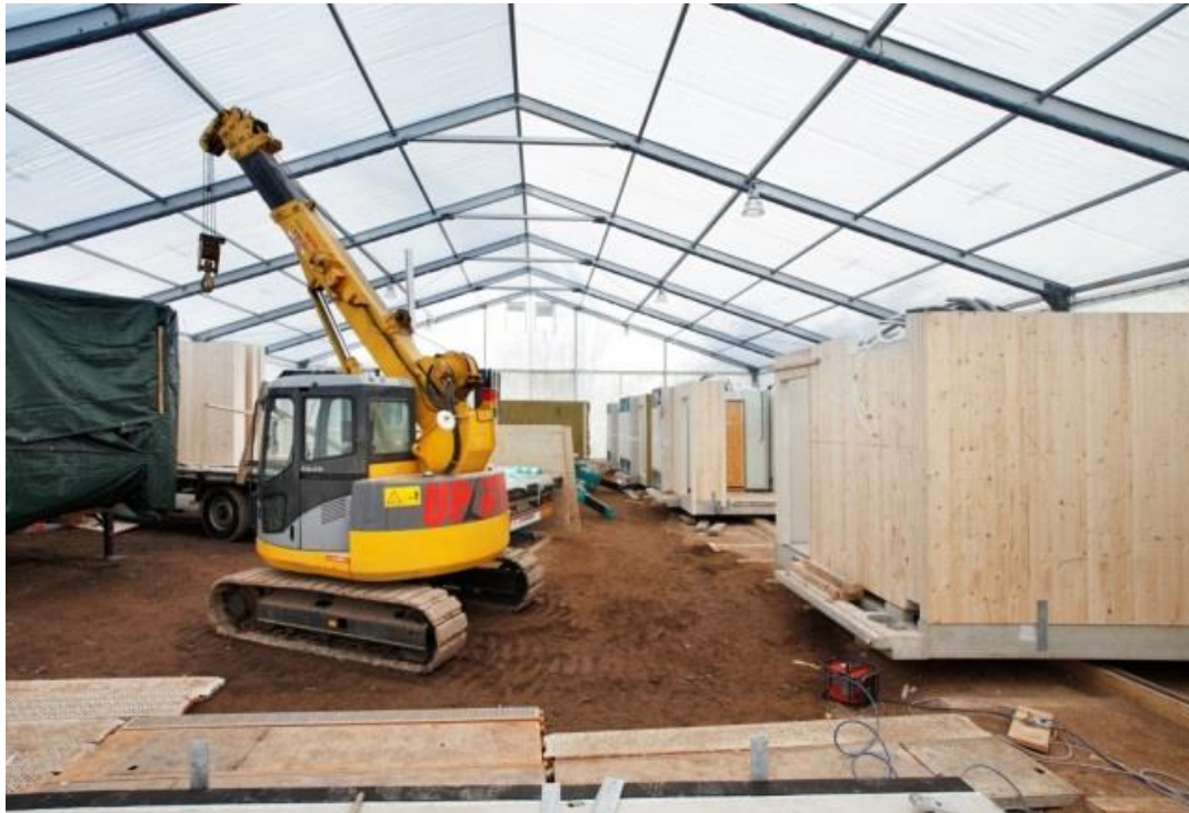
Montage von Studentenapartments in der Feldfabrik Heidelberg
